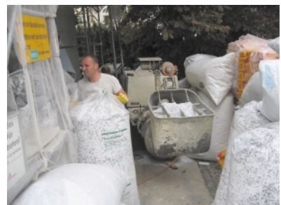
Mischen und Pumpen mit herkömmlichen Estrichmörtelmaschinen.
